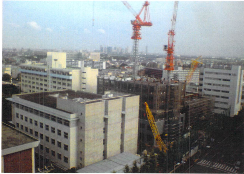
津田沼キャンパスの建築状況
